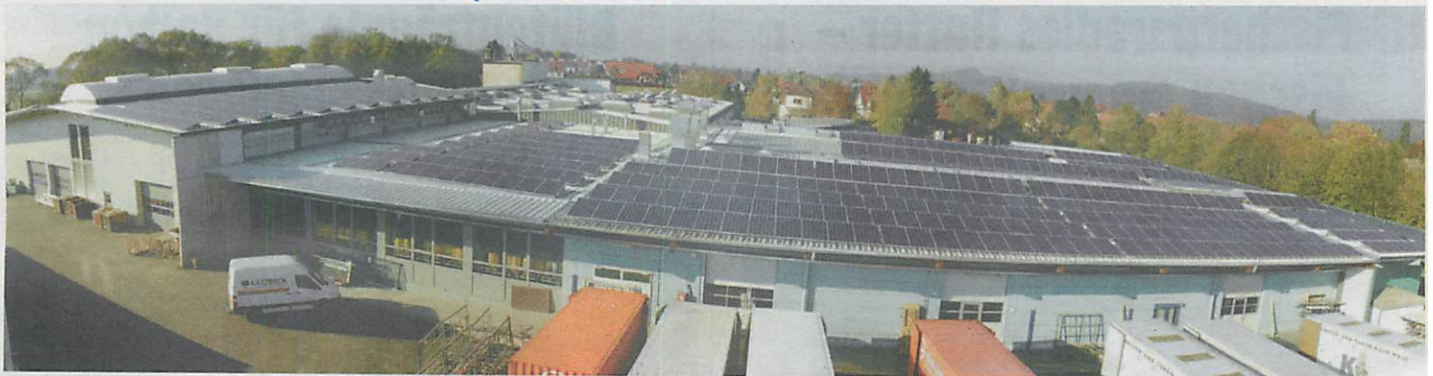
GREEN TECH Solutions sucht intensiv Freiflächen und Dächer in Österreich als Standorte für künftige Photovoltaik-Anlagen
