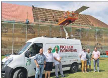
Durch die IPM-Handwerker von Pichler-Wohnbau unglaublich schnelle Dachdeckung. Das Foto zeigt Holzbaumeister Alexander Jäger, Dr. Ludwig Ems, Josef Kottulinsky, Hans Kottulinsky, DI Werner Erhart und Ing. Manfred Pichler.
